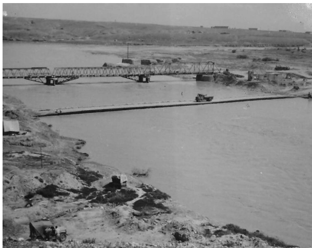
پل کمانه - جسر نادری
