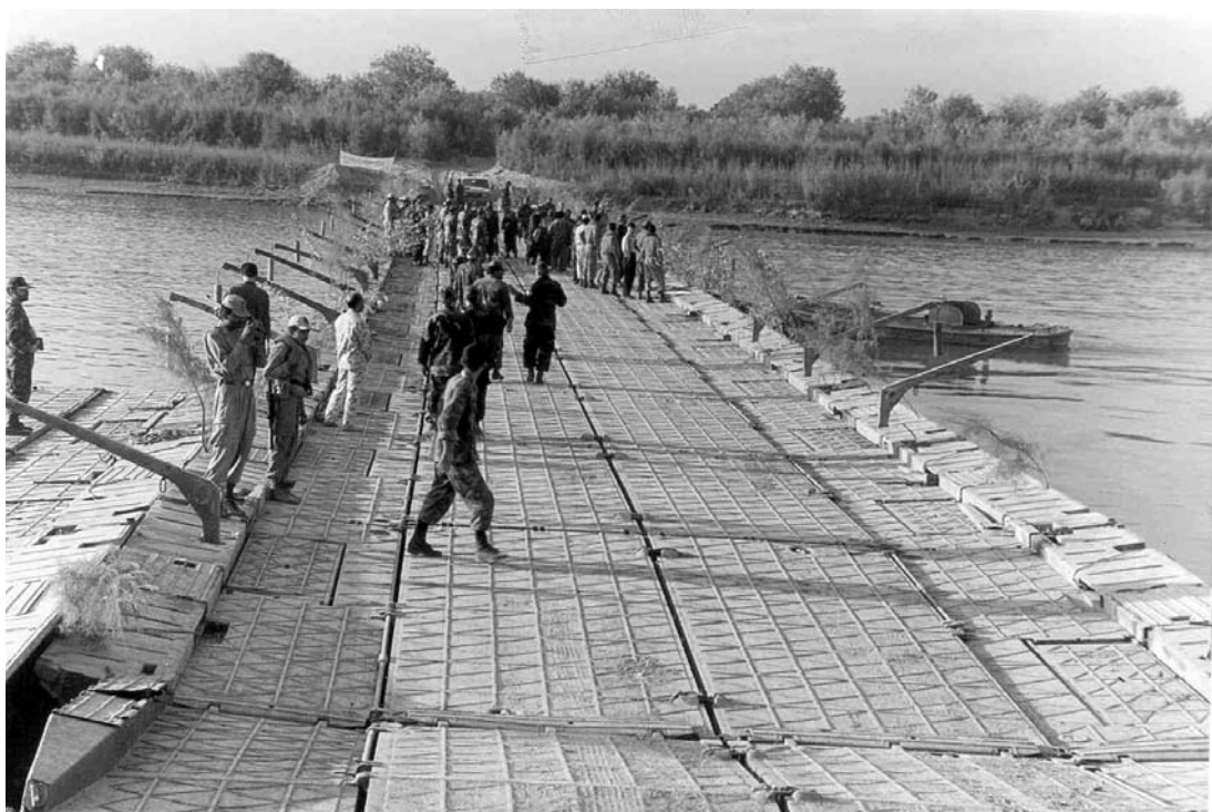
پل احدائی بر روی رودخانه کارون (محل عبور قرارگاه فتح)
