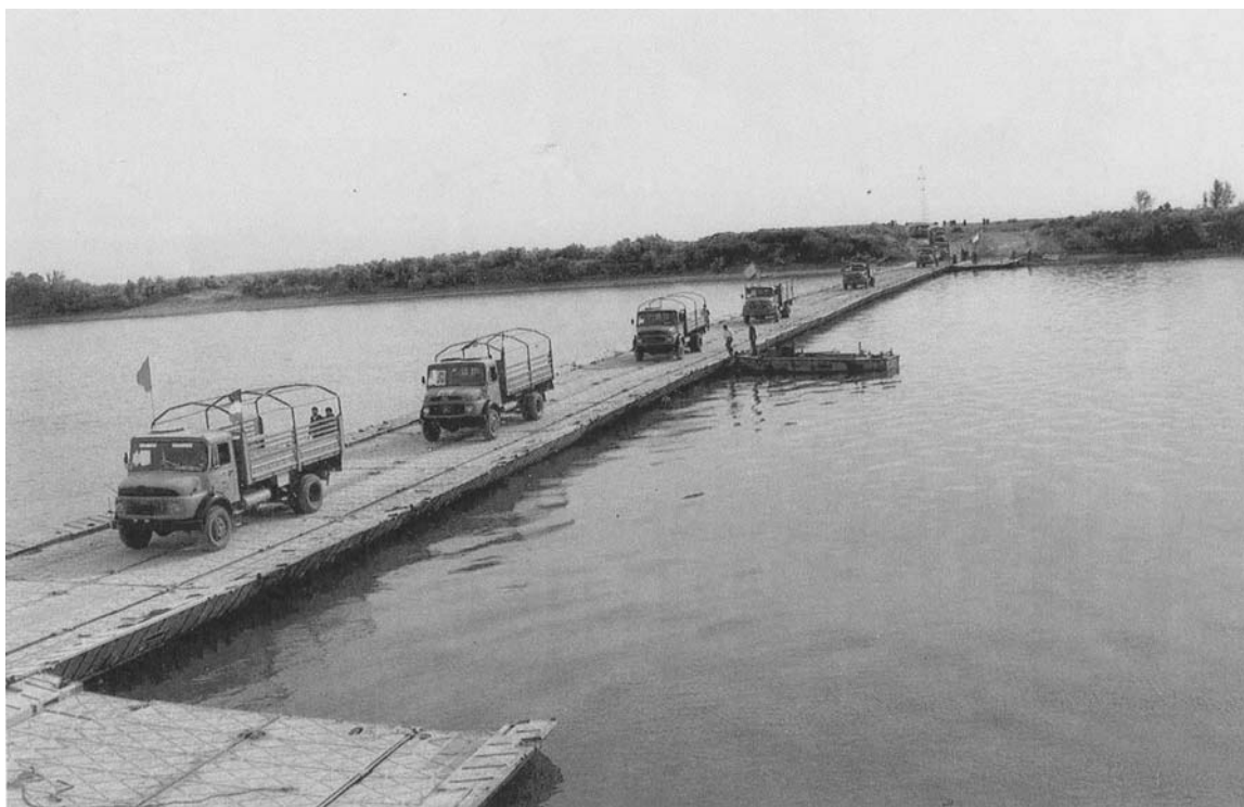
نمایی از عبور یگان‌ها از یکی از پل‌های شناور روی رودخانه کارون
