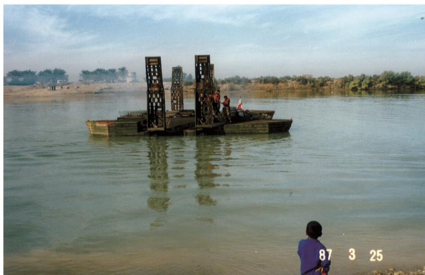
اس . پی . جی شناوری آهنین بر روی آب . یکی دیگر از پلهای شناور نقش آفرین در عملیات بیت المقدس
