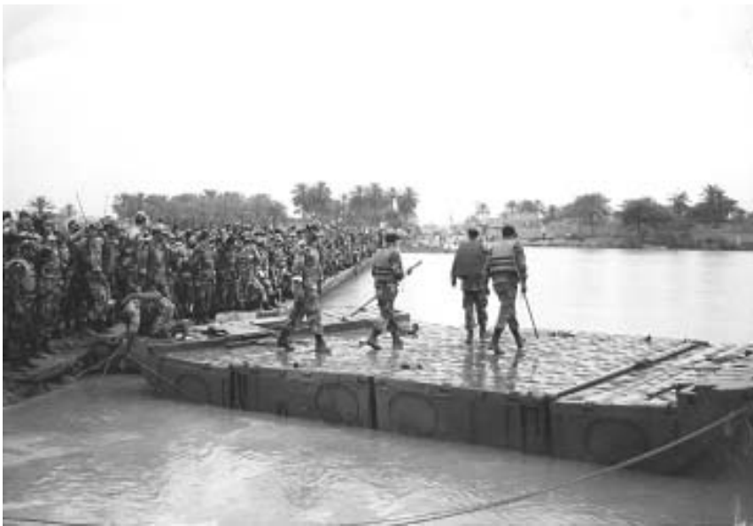
پرسنل گردان ۴۲۲ در حال نصب پل شناور بر روی رودخانه کارون می باشند
