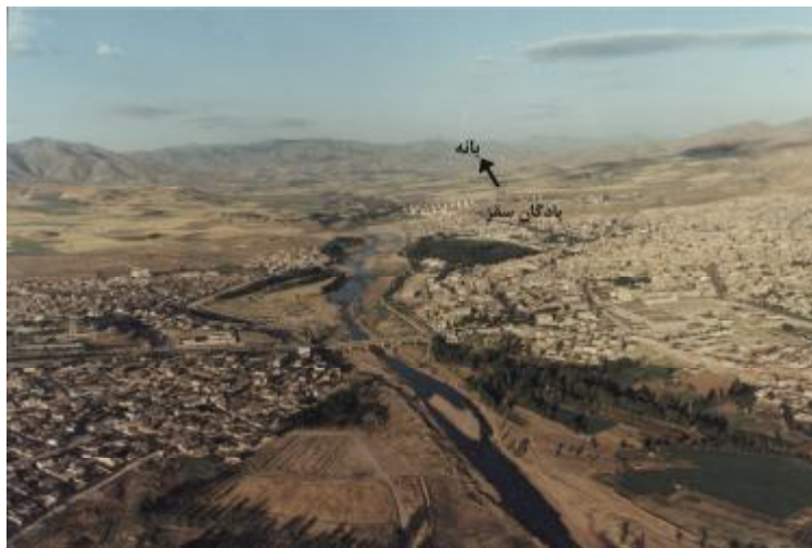
نمایی از پل، پادگان و ارتفاعات شمالی و غربی شهر سقز
