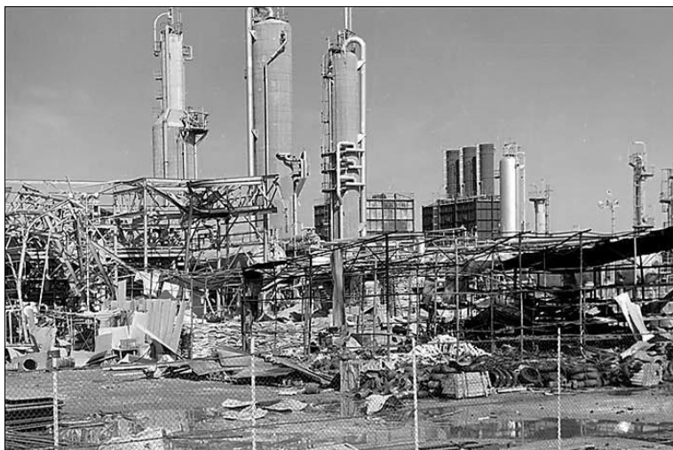
شکل ۳: خرابی‌های ناشی از بمباران تأسیسات نفتی
